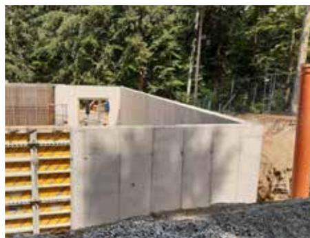
Das Gebäude für den Hochbehälter wird ebenfalls über den Sommer errichtet. Der Schalungsbau ist voll im Gange. Mit dem Innenausbau wird im September begonnen. Kernstück sind zwei Nirobehälter mit je 150.000 Liter Fassungsvermögen. Der neue Hochbehälter hat für die Versorgung der hochgelegenen Ortsteile Winden/Windegg und Lina große Bedeutung. Die Feuerwehr freut sich über neue Hydranten und größeren Druck in der Wasserleitung, was im Ernstfall großen Vorteil hat.
