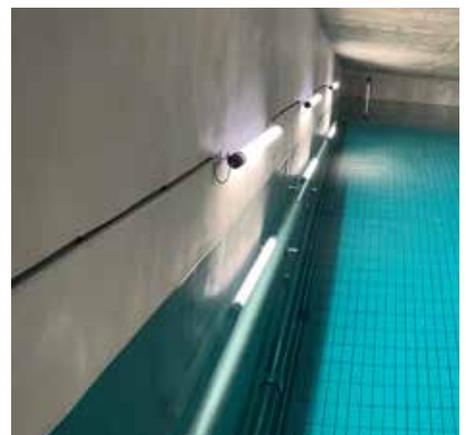
Das Ergebnis der Sanierung kann sich sehen lassen. Die Betonwände wurden mit einer glatten Schutzschicht überzogen.
