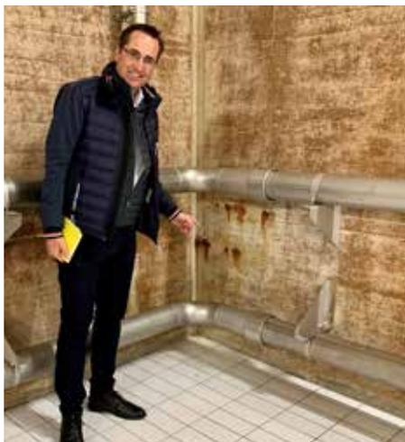
Bgm. Max Oberleitner zeigt die Baumängel im HB 1 auf: Die mangelnde Überdeckung der Eisenbewehrung und die schlechte Betongüte führten zur Verfärbung der Wände.
