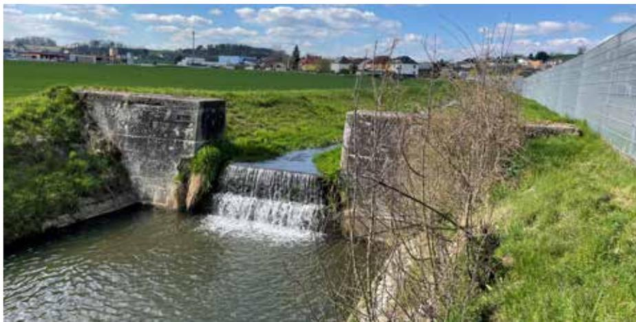
Alle Staustufen werden beseitigt, um die Fließgeschwindigkeit des Poneggenbaches zu erhöhen. Beim Car Classic Center werden die Fundamente für einen Steg für Spaziergänger genutzt.
