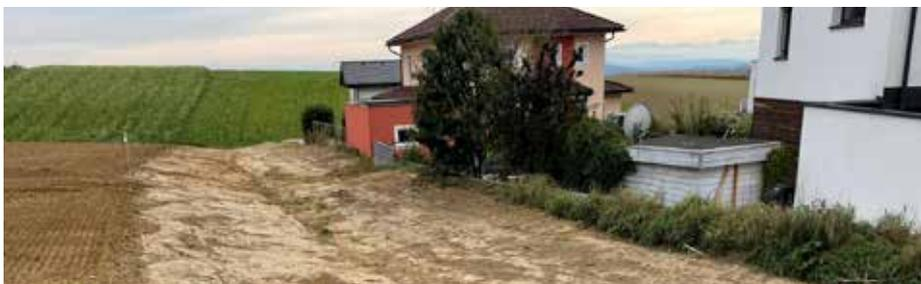
Auf der Broat'n wurden im Herbst bereits die ersten Erosionsschutzstreifen gegraben. Sie werden noch begrünt und sorgen für einen gezielten Abfluss des Hangwassers zu den Rückhaltebecken.
